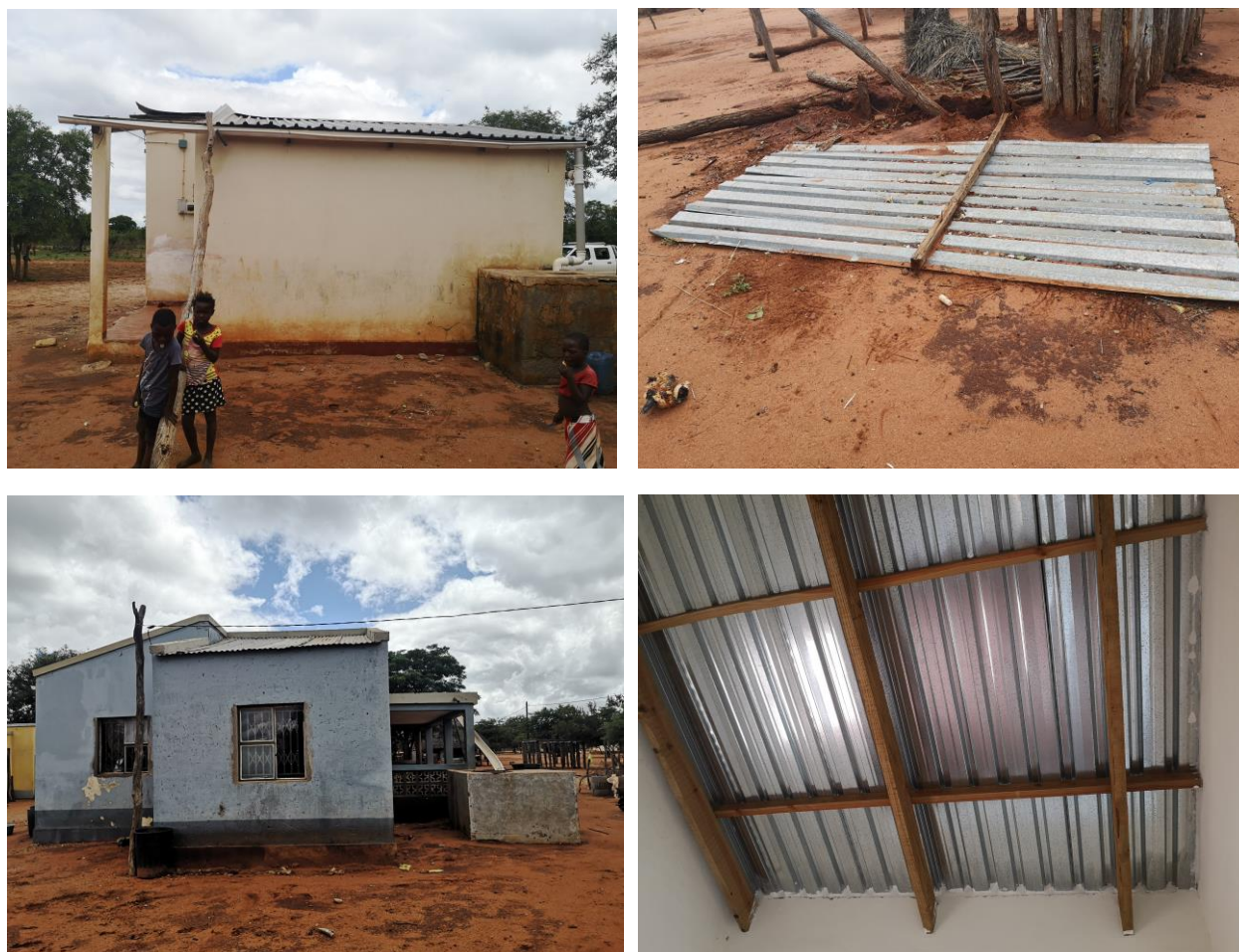
Figura 5: Imagens da cobertura das casas que estão em construção na comunidade de Canhane para os reassentados de Mavodze. (Fotografia: Issufo Tankar)
