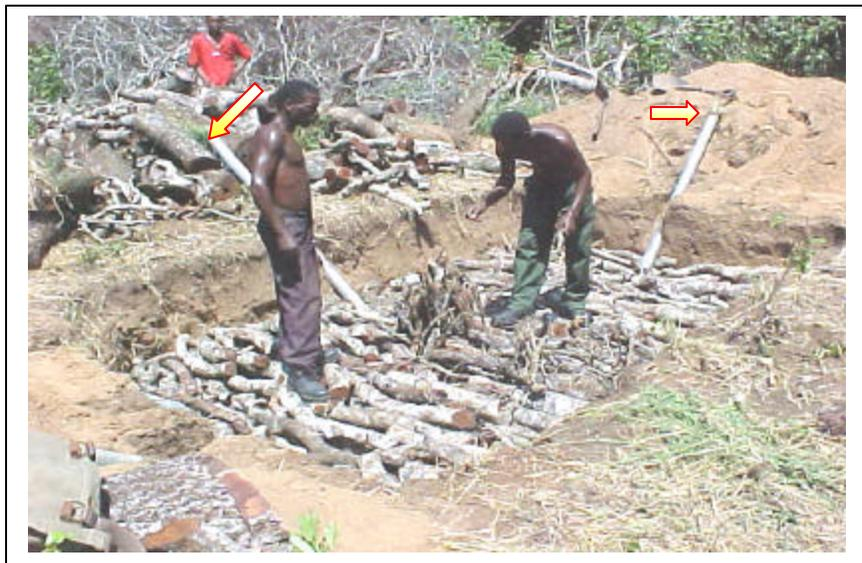
**FIGURA 8 PREENCHIMENTO DA COVA COM LENHA DE MODO A FORMAR UMA PIRÂMIDE, COM OS TUBOS DE AREAÇÃO JÁ MONTADOS**
