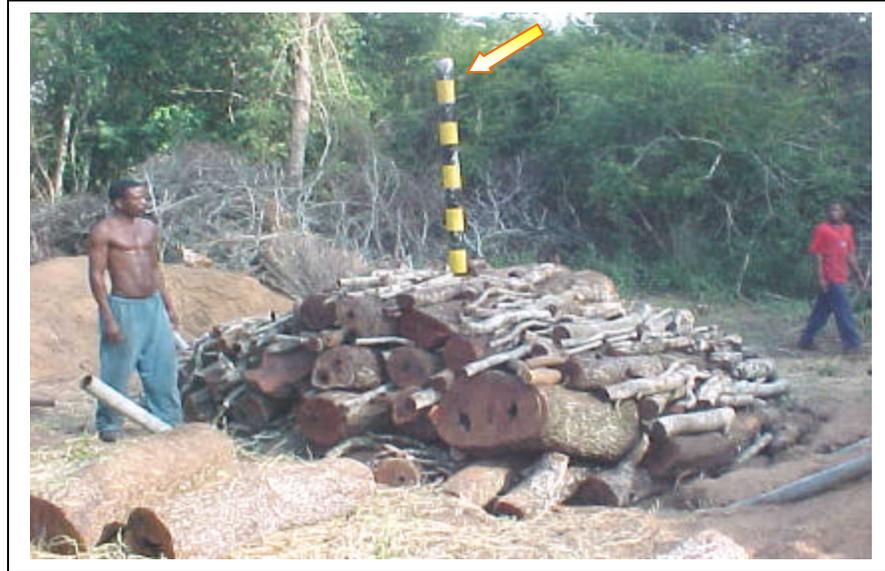
**FIGURA 9**      **FORMATO PIRAMIDAL DA ARRUMAÇÃO DA LENHA E TUBO DA CHAMINÉ COLOCADO**
