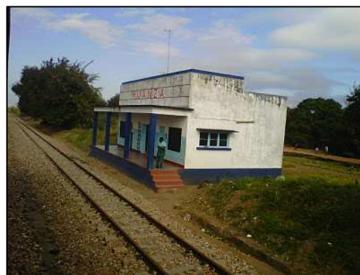
Figura 28: Estação de Muanza
