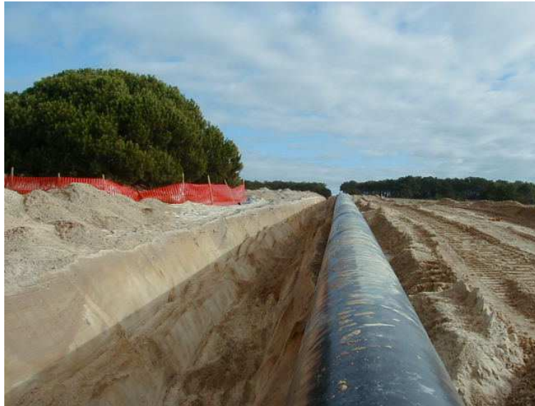
Figura 3-5 – Exemplo de obra para instalação de um gasoduto (vala aberta e tubagem preparada para ser colocada)
