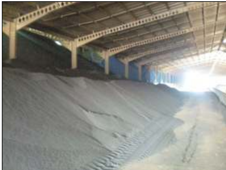
Gravura 3.4: Alpendre de Armazenagem dos produtos
