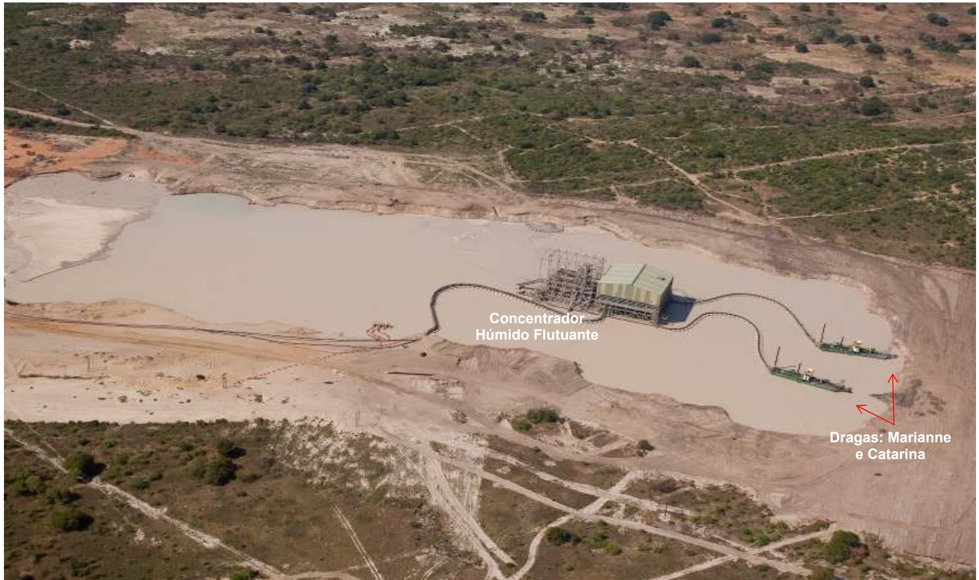
Gravura 3.1: Vista aérea do Concentrador Húmido Flutuante (WCP) A do Projecto de Areias Pesadas nas planícies de Namalope (Foto por: Tom Steytler – Novembro de 2007)
