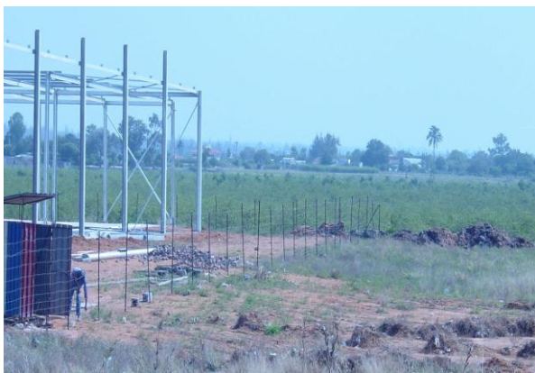
Figura 33: Expansão urbana (destruição da área de mangal para construção do centro comercial Súper Marés, cidade de Maputo)
