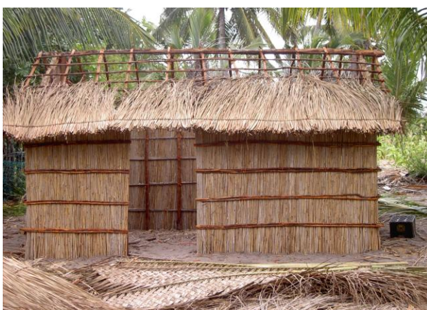
Figura 35: Estacas e ripas extraídas de espécies lenhosas de mangal para a construção de habitações (Reserva Florestal de Pomene)
